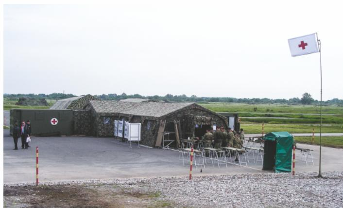
Сооружения мобильные (палатки) с наружным каркасом СМ.ПКн-36, СМ.ПКн-52 и сооружения мобильные (палатки) со сборно-складным наружным каркасом СМ.ПКн-30, СМ.ПКн-58 стыкуются между собой:
